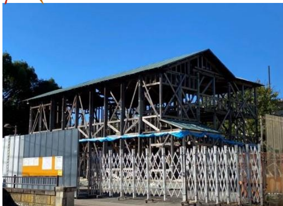
修復工事が再開された旧鎌倉図書館 (2021.11.11 撮影)
