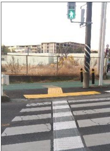
音声信号とエスコートゾーン (視覚障害者が安全に渡れるよう 設置した突起形状の道路横断帯) 設置の富士塚小学校入口交差点
