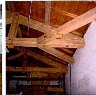
C 子ども室 2 に活用予定の部屋上部
