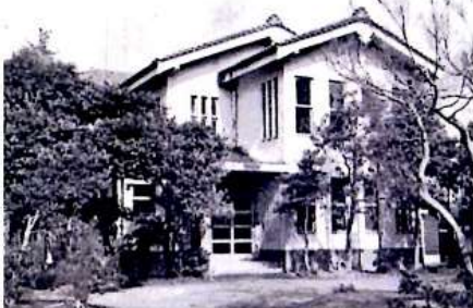
竣工当初と考えられる玄関まわり（南側）
